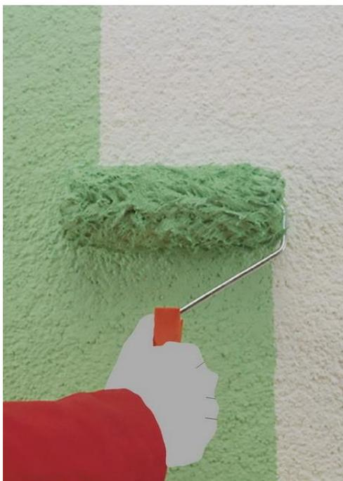
Рисунок 25 – Нанесение окрасочных составов с помощью валика
