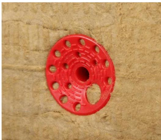
**Рисунок 15 – Установка дюбеля с шайбой**
