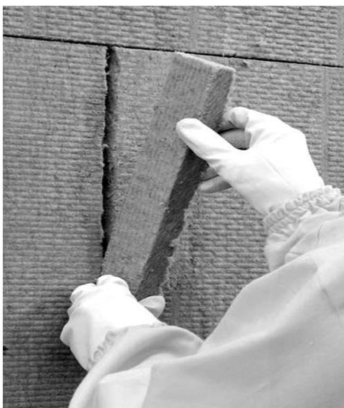
**Рисунок 12.1 – Заделка щелей между теплоизоляционными плитами**
