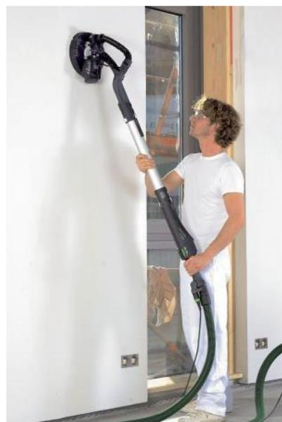
Рисунок 24 – Механизированное шлифование
