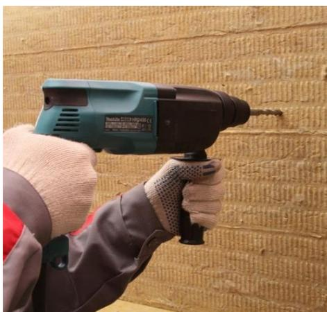
**Рисунок 14 – Сверление отверстий электродрелью**
