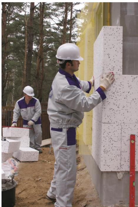
Рисунок 10 – Перевязка плит на углу здания
