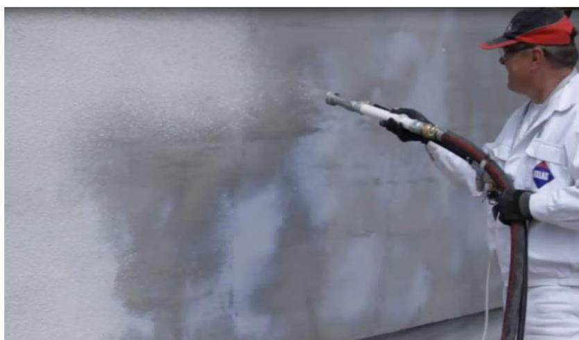
Рисунок 22 – Нанесение защитно-отделочного штукатурного состава
