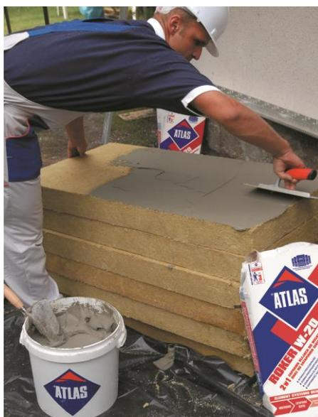
**Рисунок 9 – Нанесение клеевого состава на теплоизоляционную плиту сплошным методом**
