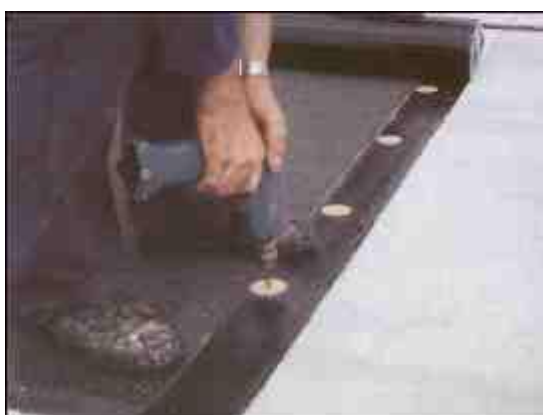
Рисунок 6 – Монтаж нижнего слоя кровельного ковра
