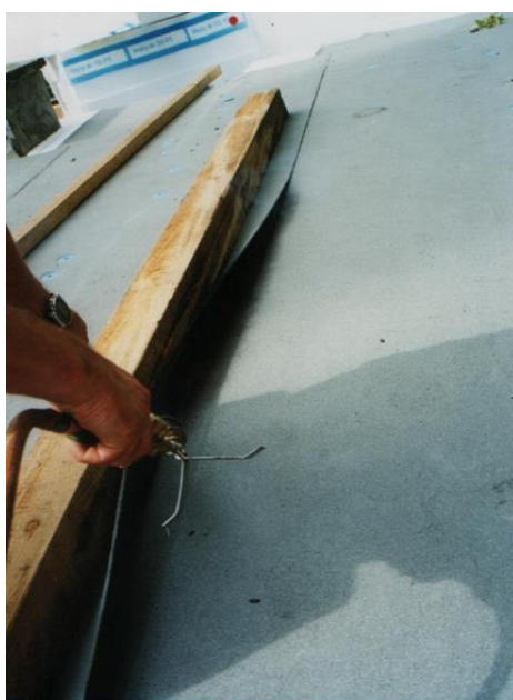
Рисунок 10 – Устройство кровли по пенополистиролу с помощью деревянного бруса
