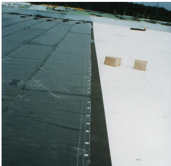
Рисунок 9 – Устройство нижнего слоя кровельного ковра по пенополистиролу
