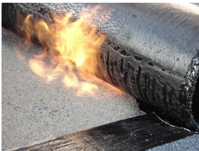
Рисунок 12 – Образование валика битумного вяжущего
