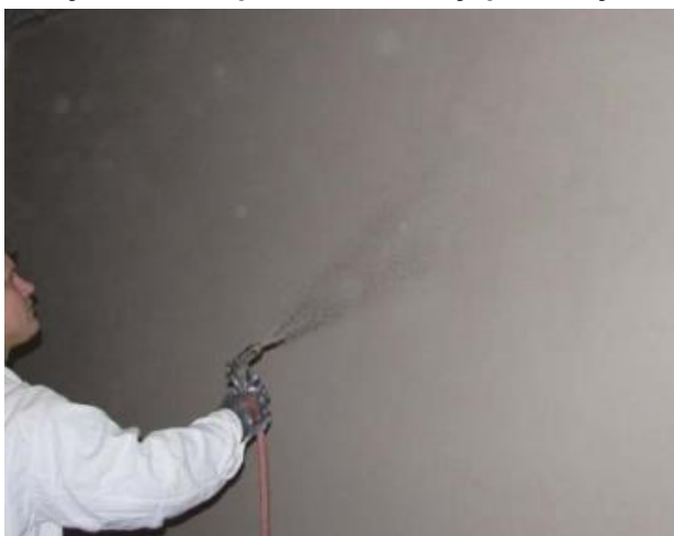
Рисунок 9 – Орошение поверхности водой
