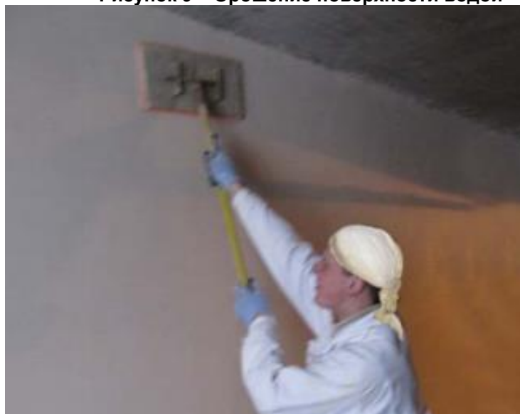
Рисунок 10 – Затирка поверхности теркой с губкой
