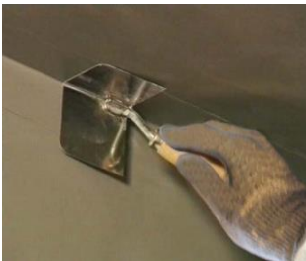
Рисунок 8 – Выравнивание внутренних углов
