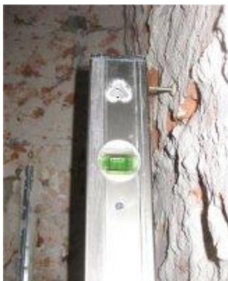
Рисунок 4 – Провешивание стен уровнем с правилом
