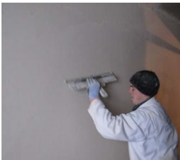
Рисунок 7 – Окончательное выравнивание поверхности шпателем
