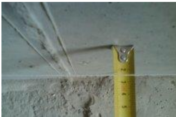
Рисунок 5 – Измерение величины отклонения
