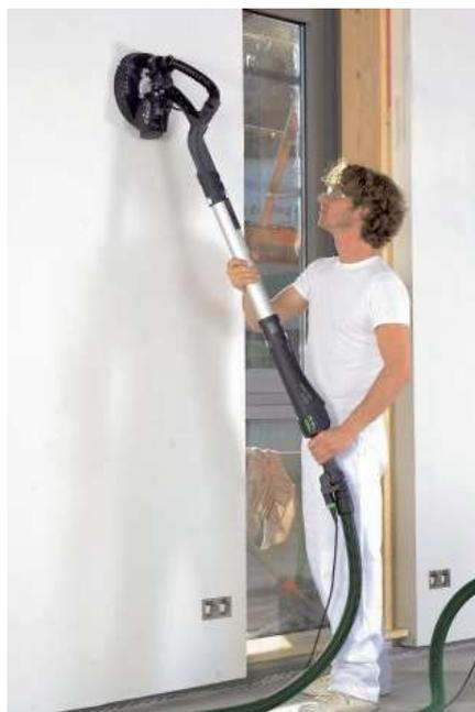
Рисунок 6 - Механизированное шлифование
