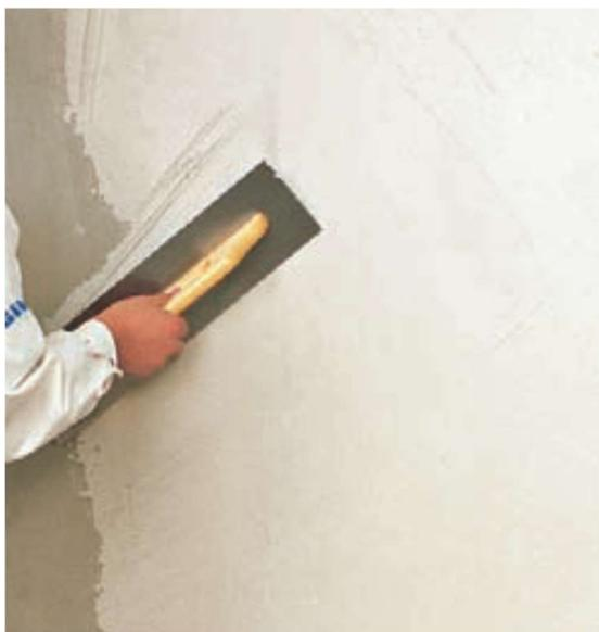
Рисунок 4 - *Нанесение на стену*
