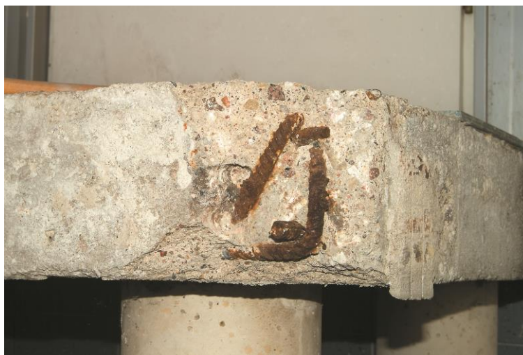
Рисунок 1 – Участок, который необходимо восстановить ремонтными составами
