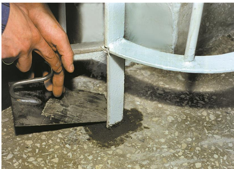
Рисунок 6 – Анкеровка элемента ограждения
