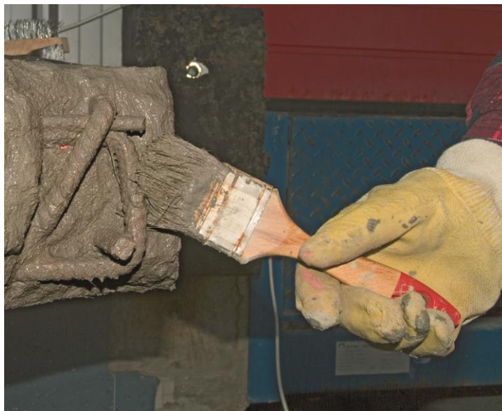
Рисунок 3 – Грунтование поверхности
