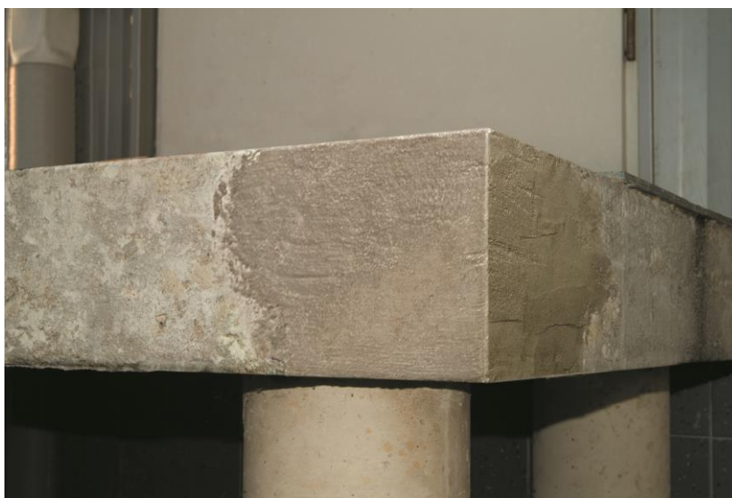
Рисунок 5 – Зашпатлеванная поверхность
