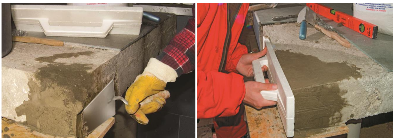
Рисунок 4 – Нанесение ремонтного слоя
